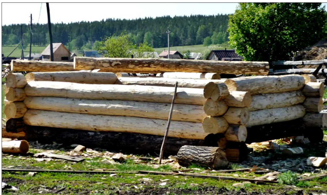
Рис. 3. Венцы сруба, соединенные кётес картини, савринкке карт «в угол» (РБ, Зилаирский р-н, с. Ивано-Кувалат, 2010 г., фото автора)
