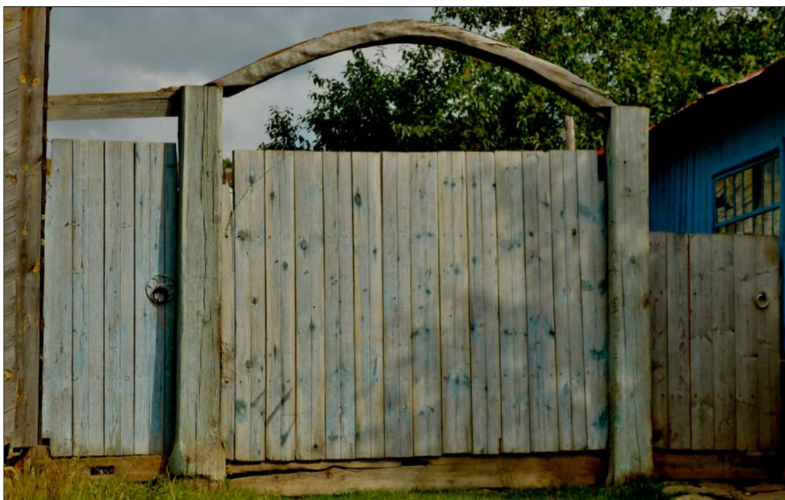
Рис. 12. Ворота, увенчанные дугой, заменившей двускатное перекрытие (РБ, Зилаирский р-н, с. Ивано-Кувалат, 2009 г., фото автора)
