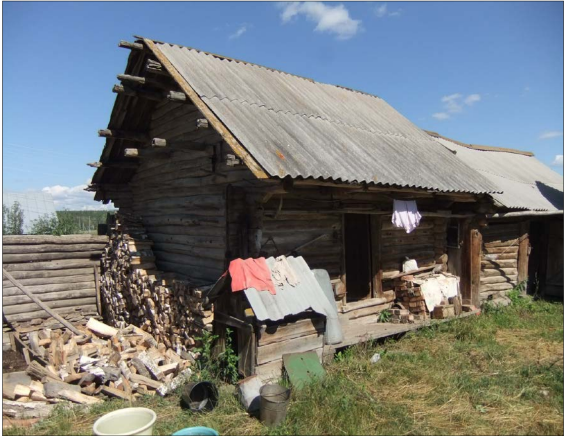
Рис. 3. Клеть на самцах, покрытая тесом, закрытым листами шифера (РБ, Зилаирский р-н, с. Ивано-Кувалат, 2013 г., фото автора)
