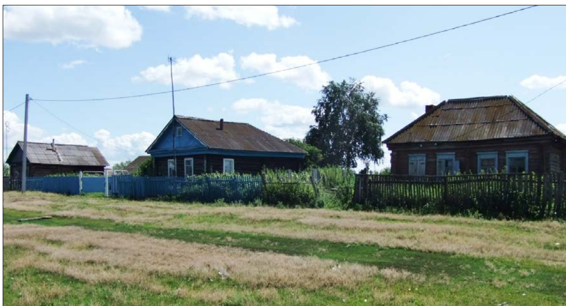
Рис. 7. Двускатная, трехскатная и шатровая крыши (РБ, Гафурийский р-н, с. Антоновка, 2011 г., фото автора)
