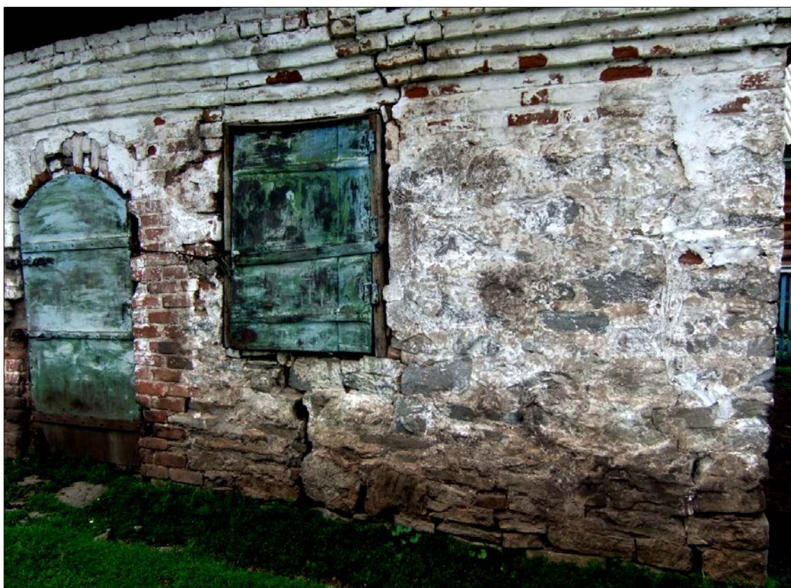
Рис. 17. Фрагмент стены дореволюционного магазина, построенного из природного камня и кирпича, принадлежавшего Василию Евдокимовичу Иванову (РБ, Гафурийский р-н, с. Антоновка, 2011 г., фото автора)
