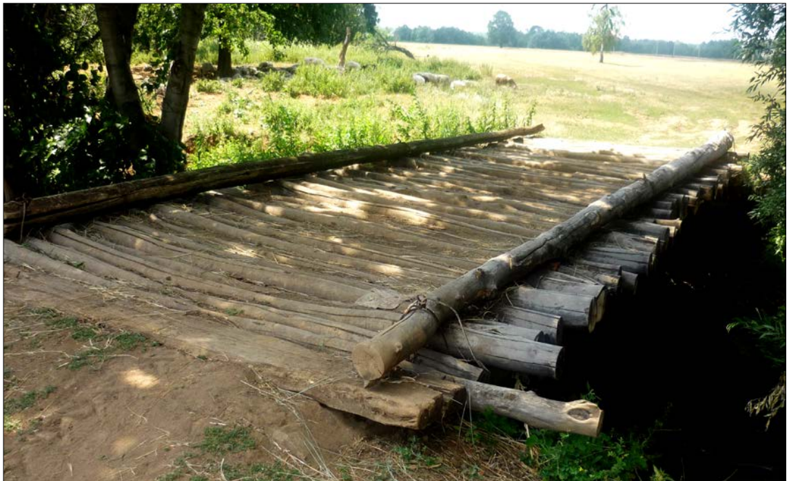
Рис. 5. Деревенский мост через реку (РБ, Бакалинский р-н, д. Юльtimiровка, 2010 г., фото автора)
