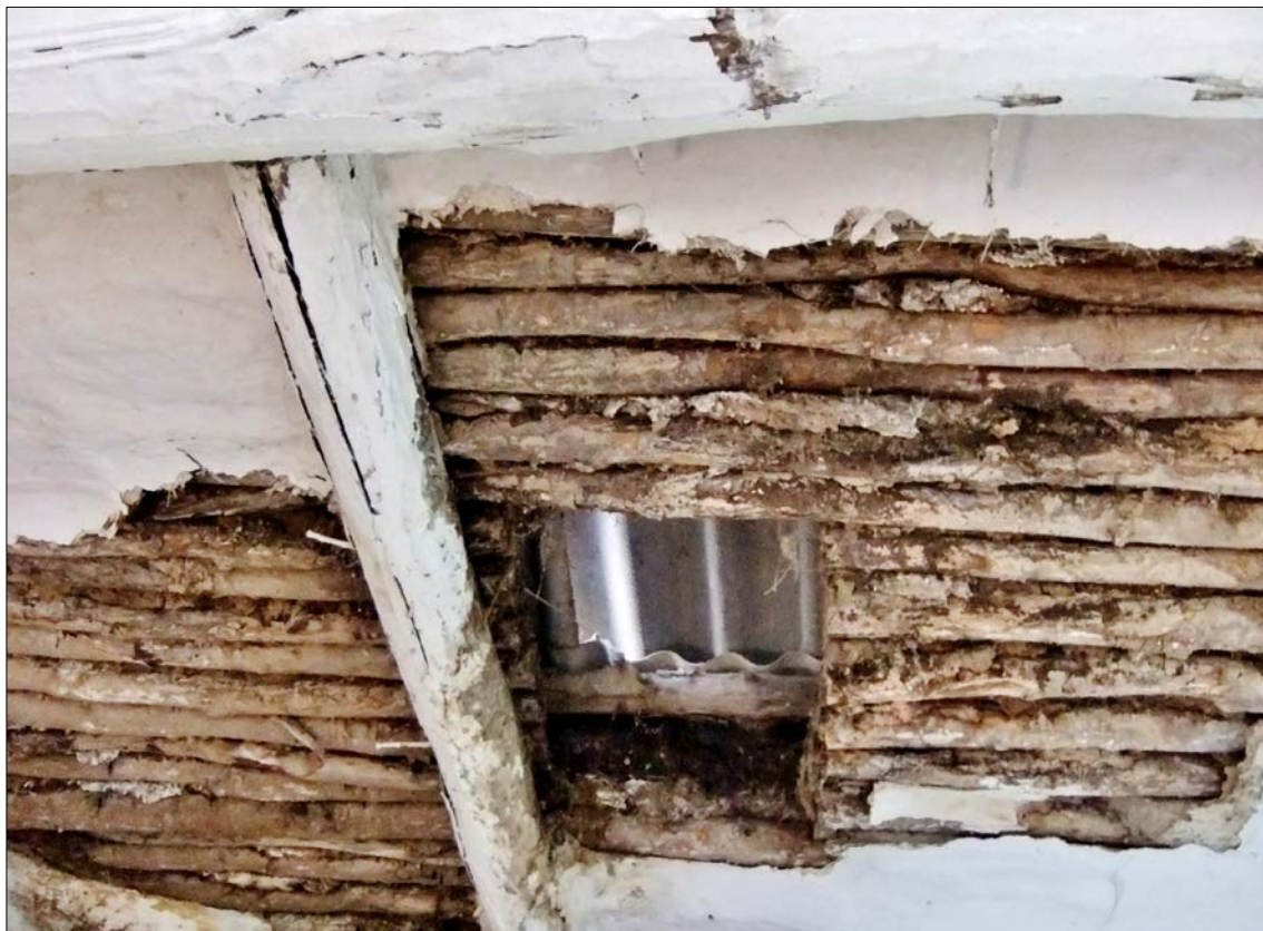
Рис. 9. Фрагмент потолка из жердей, промазанных глиняным раствором (РБ, Хайбуллинский р-н, д. Пугачево, 2010 г., фото автора)
