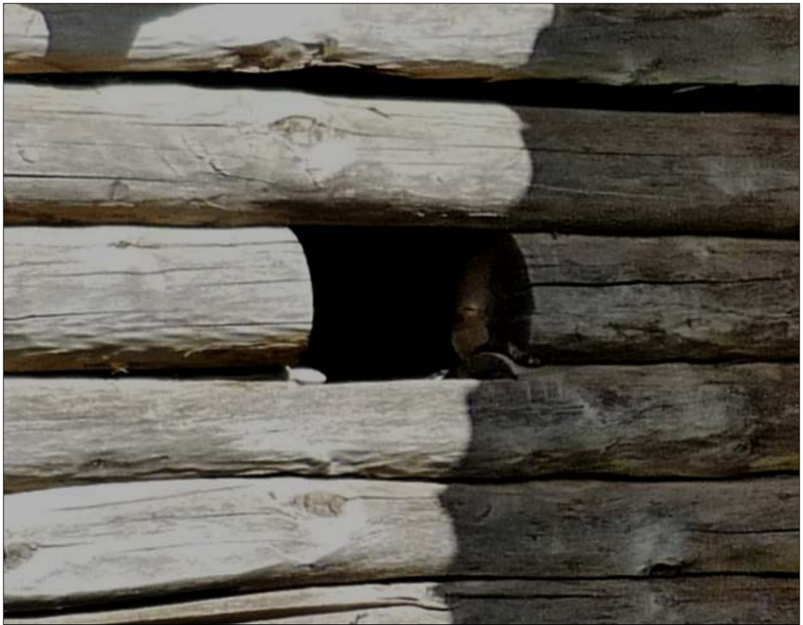
Рис. 7. Дымовое отверстие в банной стене, противоположной двери (РБ, Бакалинский р-н, с. Ахманово, 2010 г., фото автора)
