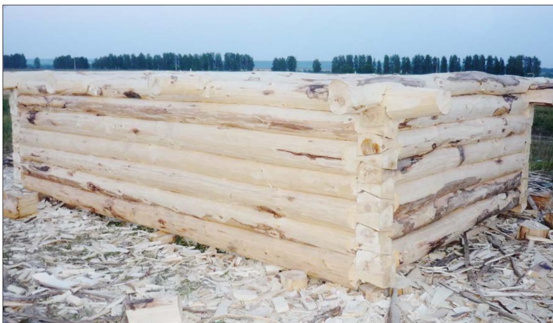
Рис. 4. Способ рубки нимёсле «в лапу» (РБ, Бакалинский р-н, д. Юльtimiровка, 2010 г., фото автора)
