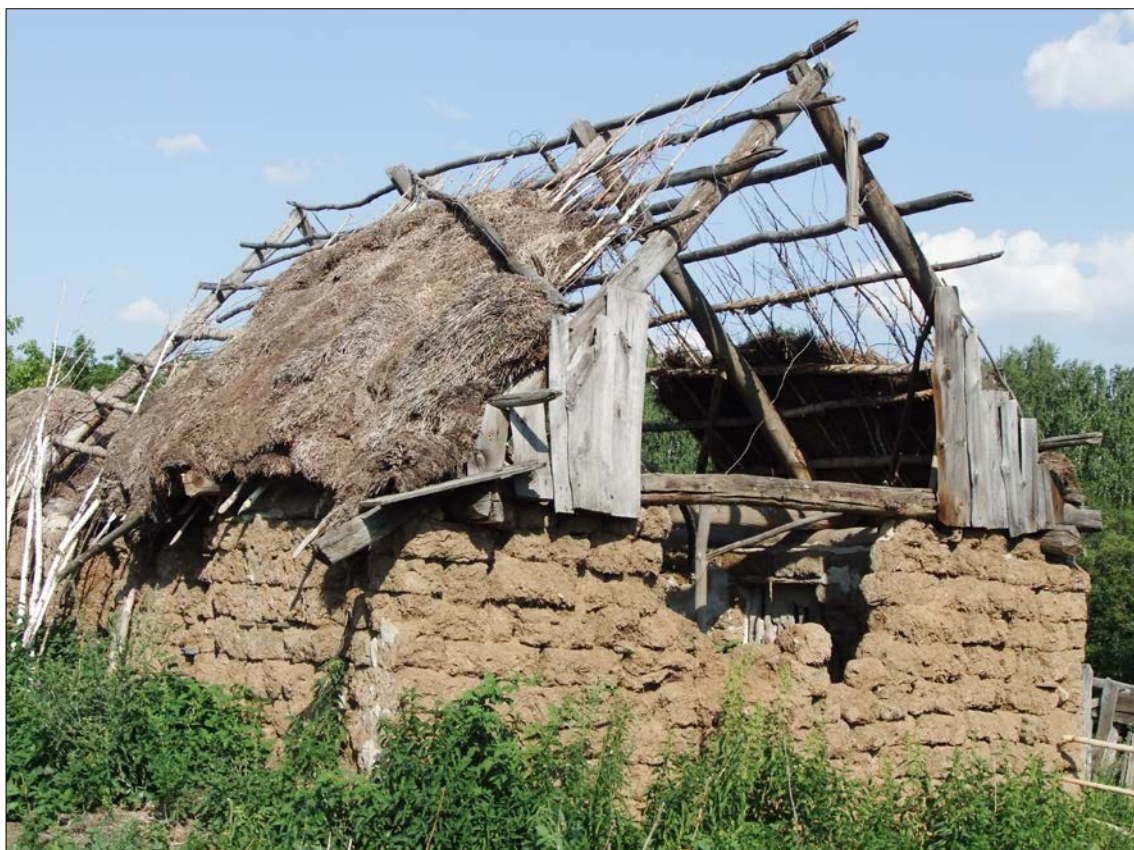
Рис. 8. Саманная постройка с соломенной кровлей (РБ, Хайбуллинский р-н, д. Пугачево, 2010 г., фото автора)
