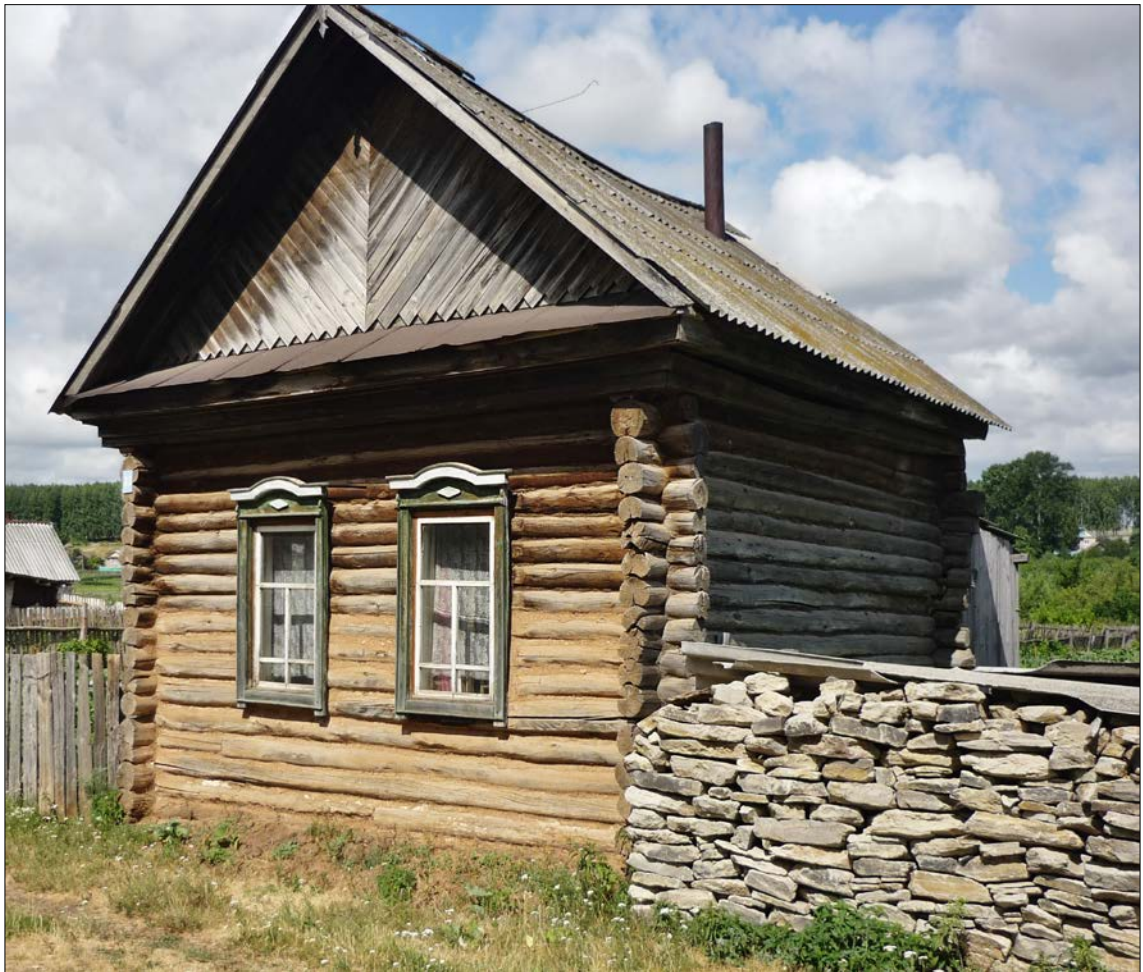
Рис. 6. Изгородь из природного камня. Нижние венцы дома заштукатурены глиной (РБ, Бакалинский р-н, с. Ахманово, 2010 г., фото автора)
