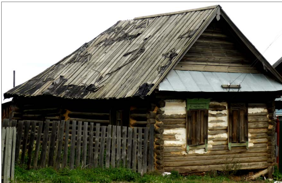
Рис. 9. Дом-пятистенки с тесовой трехскатной крышей (РБ, Зилаирский р-н, с. Ивано-Кувалат, 2009 г., фото автора)
