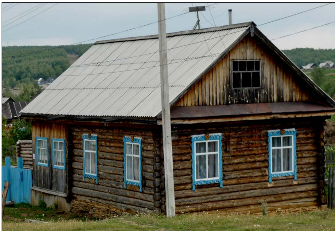
Рис. 2. Дом из соснового сруба (РБ, Зилаирский р-н, с. Ивано-Кувалат, 2009 г., фото автора)
