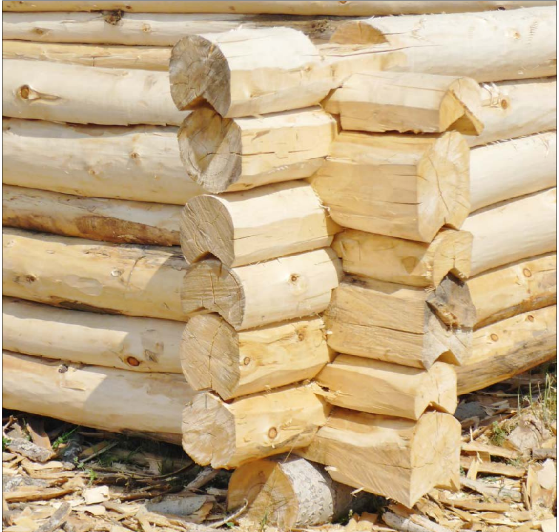
Рис. 5. Фрагмент угла способом йытй карчӗ «в охряпку» (РБ, Зилаирский р-н, с. Бердяш, 2009 г., фото автора)
