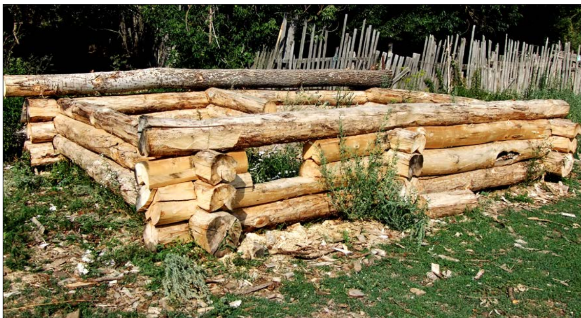
Рис. 1. Фрагмент сруба из осиновых венцов (РБ, Хайбуллинский р-н, д. Пугачево, 2010 г., фото автора)
