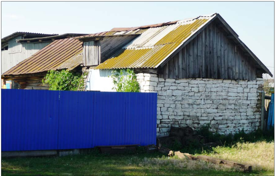
Рис. 5. Хозяйственная постройка из дикого камня (РБ, Бакалинский р-н, д. Юльtimiровка, 2010 г., фото автора)
