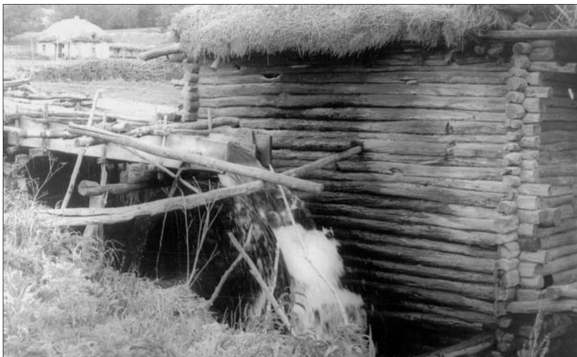
Рис. 16. Устройство водяной мельницы (БАССР, Белебеевский р-н, д. Чубукаран, 1962 г.) Фото М. В. Румянцева // НА ЧГИГН. Отд. VIII. Ед. хр. 207-1564
